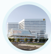
Гуанчжоуская больница GoBroad (настадии строительства)
