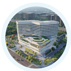
Гуанчжоу больница GoBroad (на стадии строительства)
